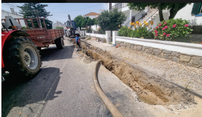
Reparação de Rede de Esgotos
