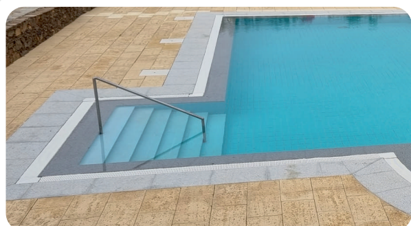
Colocação de Corrimão na Piscina Municipal Descoberta
