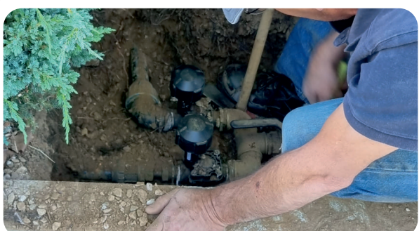
Reparação de Sistemas de Rega
