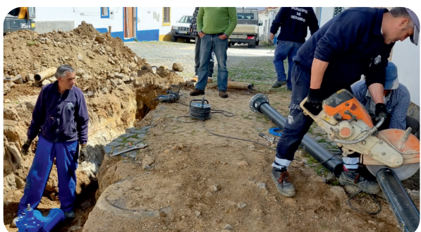
Ampliação e Reparação da Rede de Água e Saneamento
