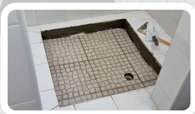
Reparação de Balneário do Posto da GNR
