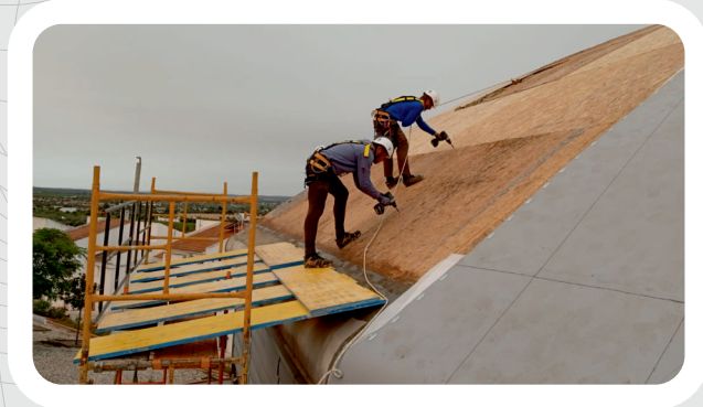
Reparação de madeiras e cobertura do Coliseu de Redondo
