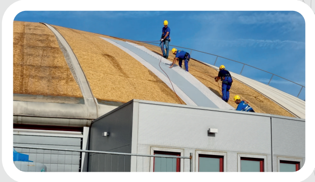
Reparação de madeiras e cobertura do Coliseu de Redondo
