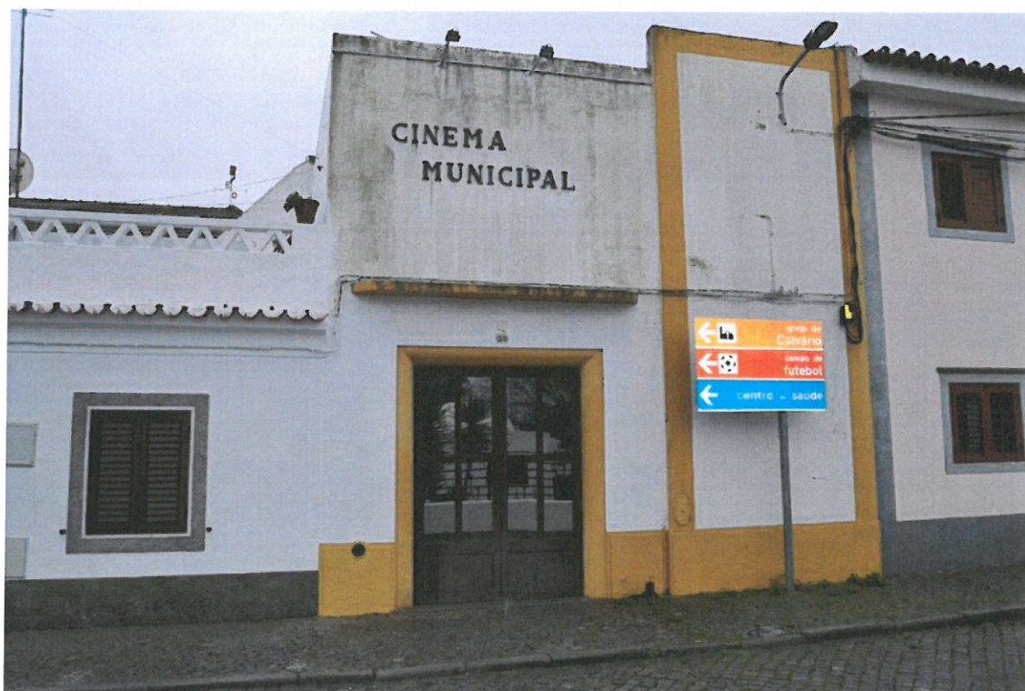
Antigo Cinema Municipal – Unidade E
