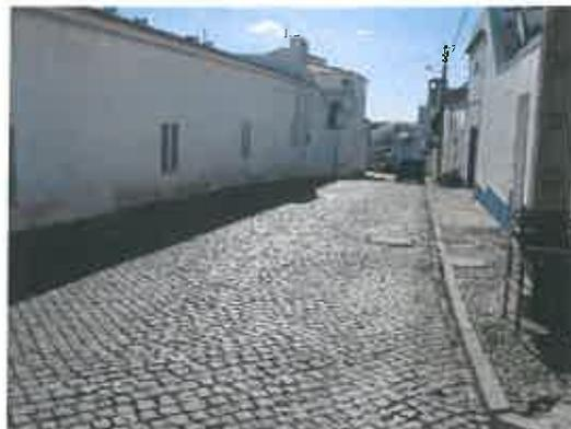
O pavimento existente é calçada irregular de basalto. A faixa de rodagem passa toda a calçada de cubos de granito de 11x11cm. A área das bolsas de estacionamento será idêntica, mas aplicada na posição ortogonal. Nos passeios será utilizada a calçada miúda de granito 5x5cm com espelho de 0,03m, assinalando-se e demarcando-se através da textura e imagem as duas áreas de tráfego distintas. Nas transições serão aplicados lancis/guias de 0,10x1,00x0,20m.
