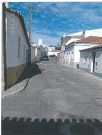
O pavimento existente é de asfalto betuminoso irregular que será removido. A faixa de rodagem será toda em cubos de granito 11x11 aplicados de forma diagonal e o estacionamento de material idêntico mas colocado de forma
