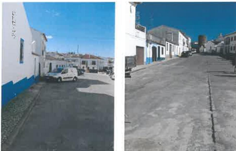
O pavimento existente é de asfalto betuminoso irregular. A faixa de rodagem passa toda a calçada de cubos de granito de 11x11cm. A área das bolsas de estacionamento será idêntica, mas aplicada na posição ortogonal. Nos passeios será utilizada a calçada miúda de granito 5x5cm com espelho de 0,03m, assinalando-se e demarcando-se através da textura e imagem as duas áreas de tráfego distintas. Nas transições serão aplicados lancis/guias de 0,10x1,00x0,20m.
