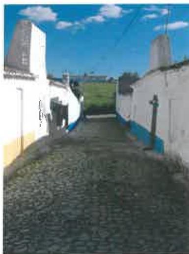
O pavimento existente é calçada irregular de basalto. A faixa de rodagem passa toda a calçada de cubos de granito de 11x11cm. A área de estacionamento será idêntica, mas aplicada na posição ortogonal. Nos
