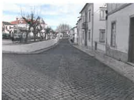
O pavimento existente é de cubos regulares que serão levantados e repostos, com reperfilamento dos passeios. A faixa de rodagem passa toda a calçada de cubos de granito de 11x11cm. A área de estacionamento será idêntica, mas aplicada na posição
