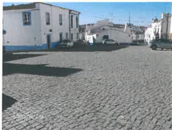
A proposta de intervenção implica o levantamento e reposição dos cubos de granito existentes com reperfilamento dos passeios e criação de bolsas de estacionamento adaptadas à convergência de vários arruamentos à praça.
