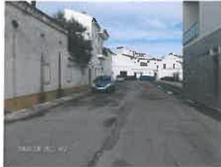
A faixa de rodagem atual é de asfalto betuminoso que será removido. A faixa de rodagem passa toda a calçada de cubos de granito de 11x11cm. A área das bolsas de estacionamento será idêntica, mas aplicada na posição ortogonal. Nos passeios será utilizada a calçada miúda de granito 5x5cm com espelho de 0,03m, assinalando-se e demarcando-se através da textura e imagem as duas áreas de tráfego distintas. Nas transições serão aplicados lancis/guias de 0,10x1,00x0,20m.
