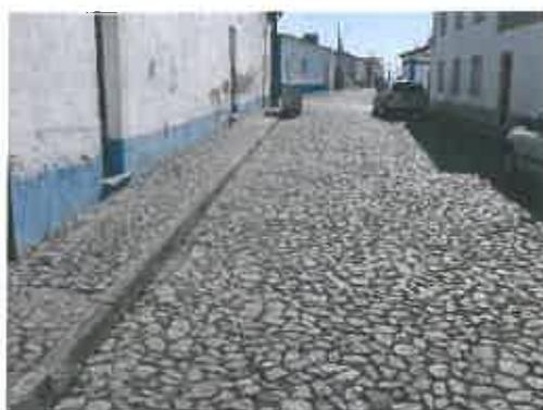
O pavimento existente é calçada irregular de basalto. A faixa de rodagem passa toda a calçada de cubos de granito de 11x11cm. A área das bolsas de estacionamento será idêntica, mas aplicada na posição ortogonal. Nos passeios será utilizada a calçada miúda de granito 5x5cm com espelho de
