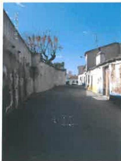
O pavimento existente é de asfalto betuminoso irregular. A faixa de rodagem passa toda a calçada de cubos de granito de 11x11cm. A área de estacionamento será idêntica, mas aplicada na posição ortogonal. Nos passeios será utilizada a calçada miúda de granito 5x5cm com espelho de 0,03m, assinalando-se e demarcando-se através da textura e imagem as duas áreas de tráfego distintas. Nas transições serão aplicados lancis/guias de 0,10x1,00x0,20m.
