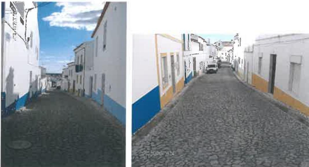
O pavimento existente é calçada irregular de basalto. A faixa de rodagem passa toda a calçada de cubos de granito de 11x11cm. A área das bolsas de estacionamento será idêntica, mas aplicada na posição ortogonal. Nos passeios será utilizada a calçada miúda de granito 5x5cm com espelho de
