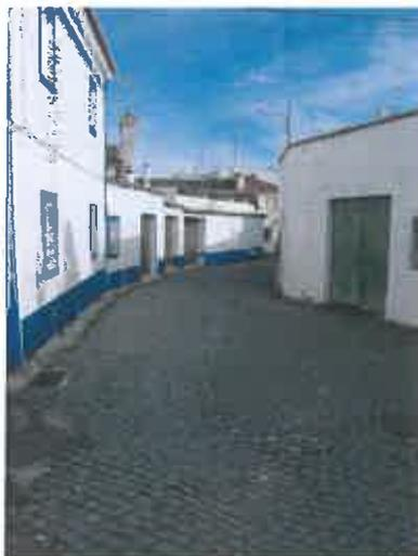
O pavimento existente é de cubos regulares que serão levantados e repostos, com reperfilamento dos passeios. A faixa de rodagem passa toda a calçada de cubos de granito de 11x11cm. A área de estacionamento será idêntica, mas aplicada na posição ortogonal. Nos passeios será utilizada a calçada miúda de granito 5x5cm com espelho de 0,03m, assinalando-se e demarcando-se através da textura e imagem as duas áreas de tráfego distintas. Nas transições serão
