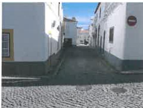
O pavimento existente é de cubos regulares que serão levantados e repostos, com reperfilamento dos passeios e criação de bolsas de estacionamento. A faixa de rodagem será toda em cubos de granito 11x11 aplicados de forma diagonal e as bolsas de estacionamento de material
