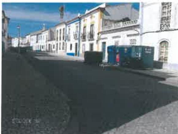
O pavimento existente é de cubos regulares que serão levantados e repostos, com reperfilamento dos passeios e criação de bolsas de
