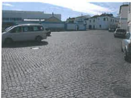
O pavimento existente é de cubos regulares que serão levantados e repostos, com reperfilamento dos passeios e criação de bolsas de estacionamento. A faixa de rodagem será toda em cubos de granito 11x11 aplicados de forma diagonal e as bolsas de estacionamento de material idêntico mas colocado de forma ortogonal. Nos passeios será utilizada a calçada miúda de granito 5x5cm com espelho de 0,03m, assinalando-se e
