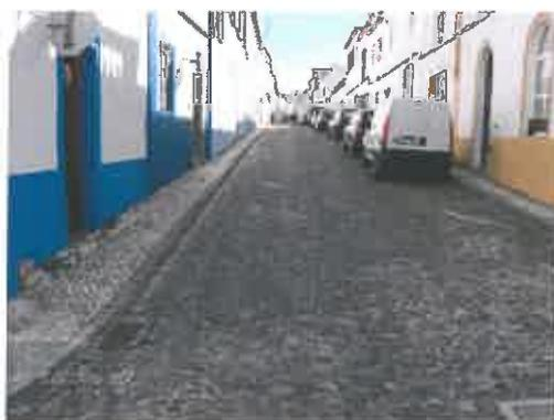
O pavimento existente é calçada irregular de basalto. A faixa de rodagem passa toda a calçada de cubos de granito de 11x11cm. A área de estacionamento será idêntica, mas aplicada na posição ortogonal. Nos passeios será utilizada a calçada miúda de granito 5x5cm com espelho de 0,03m, assinalando-se e demarcando-se através da textura e imagem as duas áreas de tráfego distintas. Nas transições serão aplicados lancis/guias de 0,10x1,00x0,20m.
