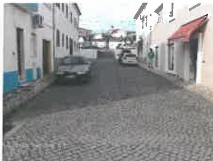
O pavimento existente é de cubos regulares que serão levantados e repostos, com reperfilamento dos passeios. A faixa de rodagem passa toda a calçada de cubos de granito de 11x11cm. A área de estacionamento será idêntica, mas aplicada na posição ortogonal. Nos passeios será utilizada a calçada miúda de granito 5x5cm com espelho de 0,03m, assinalando-se e demarcando-se através da textura e imagem as duas áreas de tráfego distintas. Nas transições serão aplicados lancis/guias de 0,10x1,00x0,20m.
