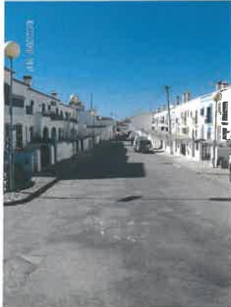
O pavimento existente é de asfalto betuminoso irregular. A faixa de rodagem passa toda a calçada de cubos de granito de 11x11cm. A área das bolsas de estacionamento será idêntica, mas aplicada na posição ortogonal. Nos passeios será utilizada a calçada miúda de granito 5x5cm com espelho de 0,03m, assinalando-se e demarcando-se através da textura e imagem as duas áreas de tráfego distintas. Nas transições serão aplicados lancis/guias de 0,10x1,00x0,20m.
