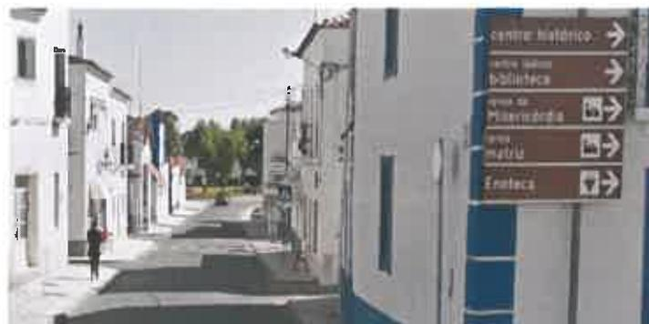
A faixa de rodagem atual é calçada regular 10x20cm. A faixa de rodagem passa toda a calçada de cubos de granito de 11x11cm. A área das bolsas de estacionamento será idêntica, mas aplicada na posição ortogonal. Nos passeios será utilizada a calçada miúda de granito 5x5cm com espelho de 0,03m, assinalando-se e demarcando-se através da textura e imagem as duas áreas de tráfego distintas. Nas transições serão aplicados lancis/guias de 0,10x1,00x0,20m.
