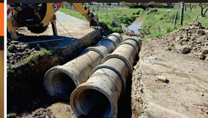
Reparação do Pontão das Vínhas
